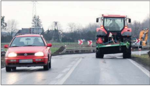
■ Na zakręcie między Dęblinem, a Stężycą należy zachować szczególną ostrożność. Utrudnienia spowodowane są budową nowego fragmentu trasy 801
