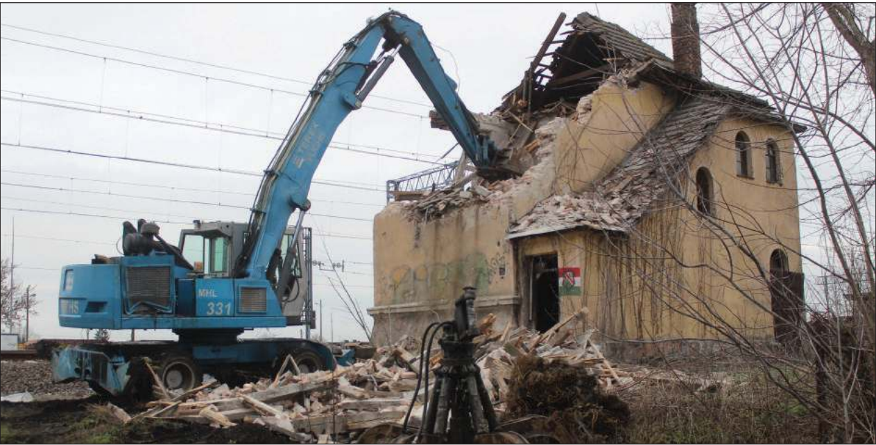
W ubiegły poniedziałek obok torów przy ul. Konopnickiej w Dęblinie rozpoczęły się prace rozbiórkowe
