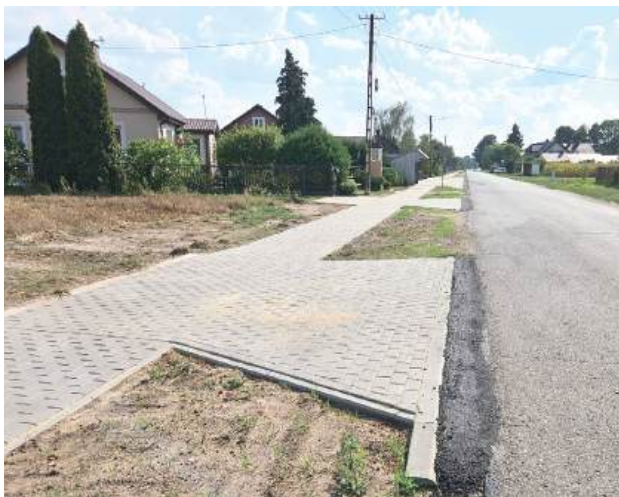
Na drodze powiatowej w Worsach wykonano m.in. zatokę autobusową
