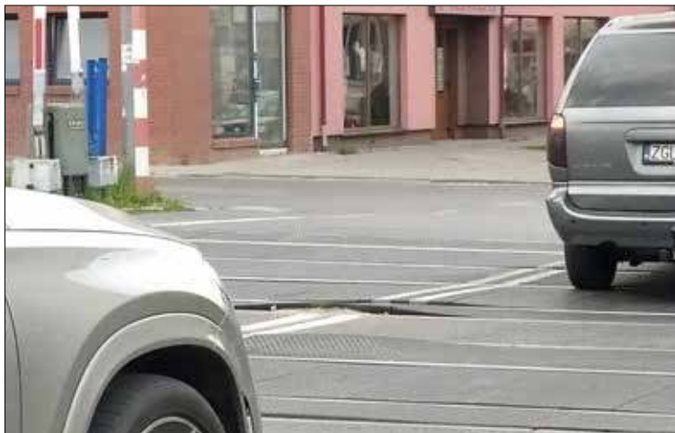
Pęknięcia widoczne są coraz bardziej i to w kilku miejscach
