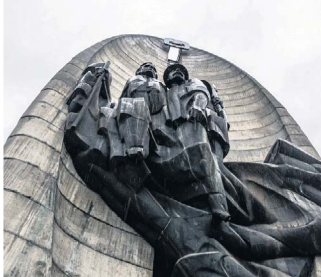
Pomnik Czynu Rewolucyjnego w Rzeszowie to zabytek, który nadaje się do remontu.
