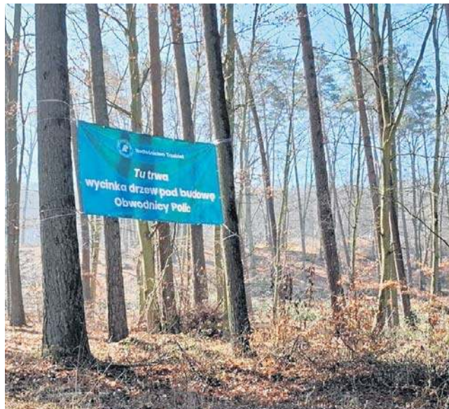
Rozpoczęcie budowy poprzedziła wycinka drzew
