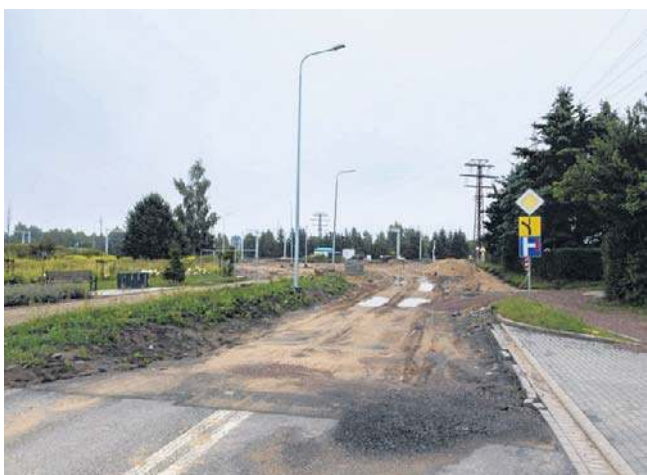
Przebudowa przejazdu kolejowego na ul. Kolejowej
