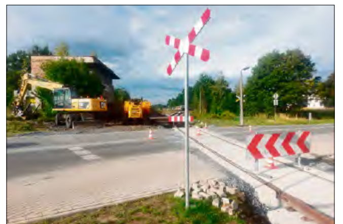
Dzięki wykonanym robotom poprawił się stan infrastruktury kolejowej oraz nawierzchni przejazdu, co wpłynie na komfort i bezpieczeństwo kierowców.
