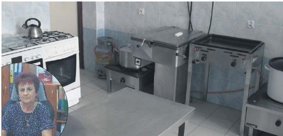
Jolanta Zawislak: Ostatni remont przeprowadzony był kilkanaście lat temu. Tak teraz wygląda kuchnia w SP w Jarczowie. Już niedługo przybędzie tam nowych gadżetów, dzięki którym gotowanie będzie jeszcze łatwiejsze i przyjemniejsze. Fot. SP Jarczów
