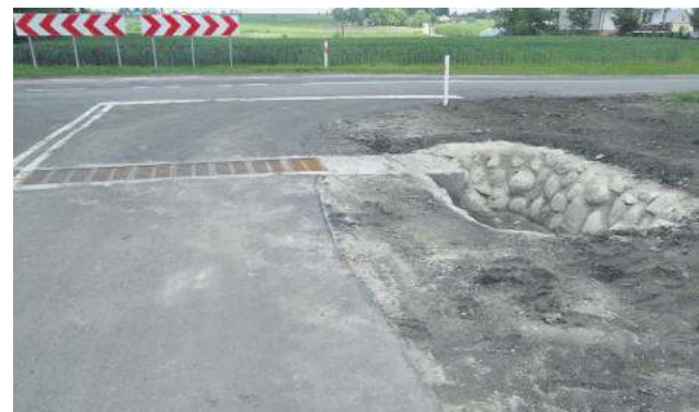
To część nowej drogi i przepustu w Żulicach.
