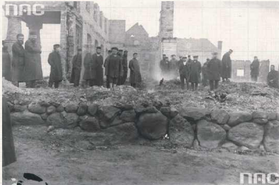
Ze zdjęcia znalezione w Narodowym Archiwum Cyfrowym, wykonanego tuż po pożarze w 1925 roku, możemy domniemywać, że rycka synagoga nie była zbyt wielka. Trudną, ale wartą przeanalizowania zagadką jest czy przy jej budowie uwzględniono też inne niż pionowe ustawienie bali wytyczne Księgi Wyjścia. Można by wtedy śmiało mówić o Rykach jako Małej Jerozolimie
