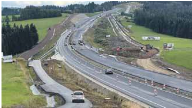
Budowa nowej zakopianki w rejonie Sołtysiej Doliny.
