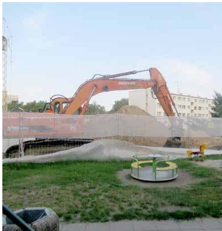
Przedszkole k. szpitala - poszerzają skarpę by postawić ogrodzenie
