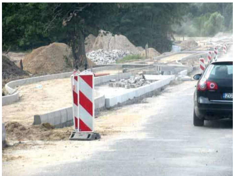
Krzywin - wygląda jak budowa autostrady, a czas leci
