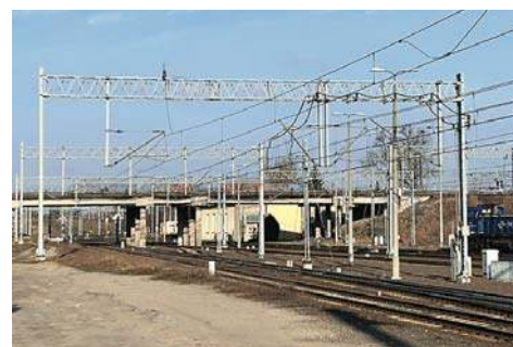
CZAS NA BUDOWĘ NOWYCH WIADUKTÓW |10
