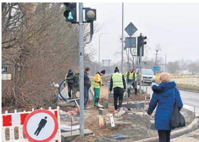
Inwestycja po północnej stronie ulicy Poznańskiej - stan na poniedziałek, 15 grudnia
