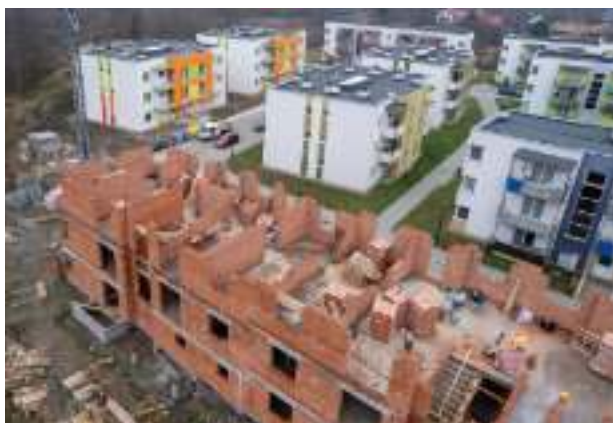
► Budowa kolejnych nowych mieszkań Fot. UM Zabrze
