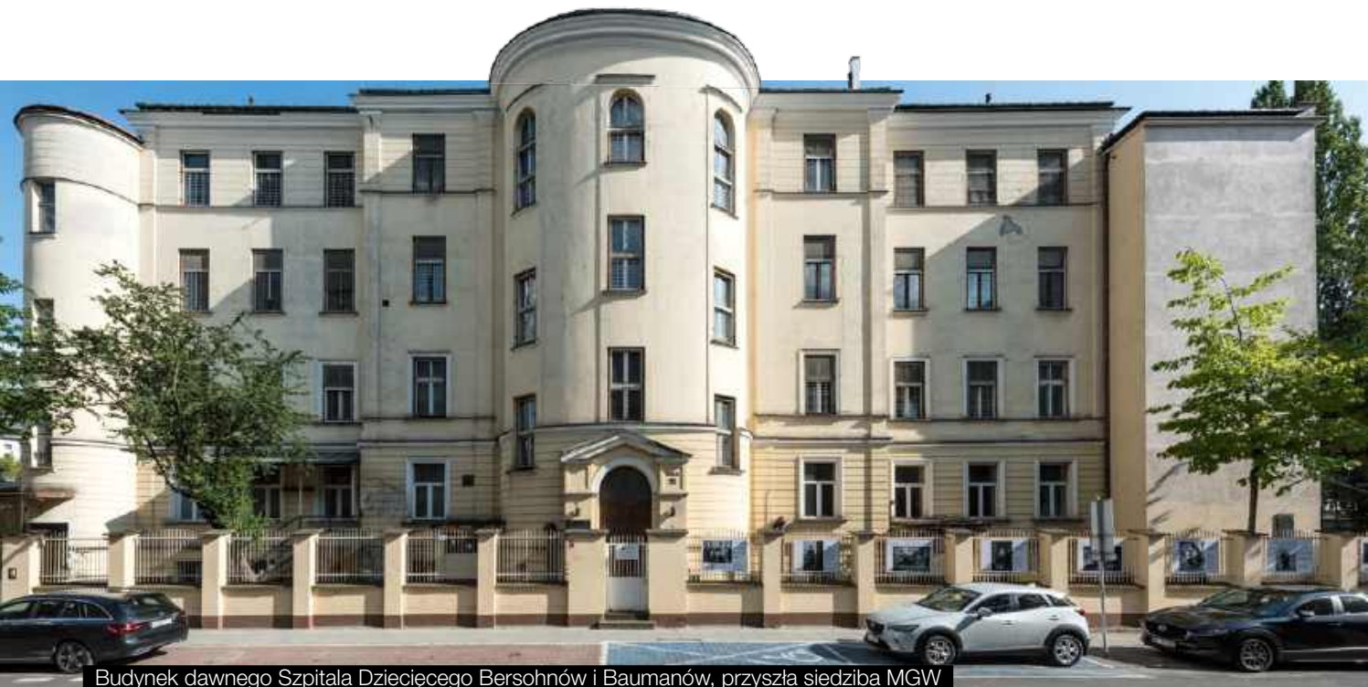
Budynek dawnego Szpitala Dziecięcego Bersohnów i Baumanów, przyszła siedziba MGW
