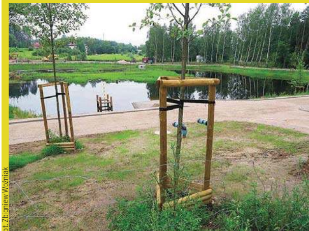
Budowa zbiornika retencyjnego na Likusach
