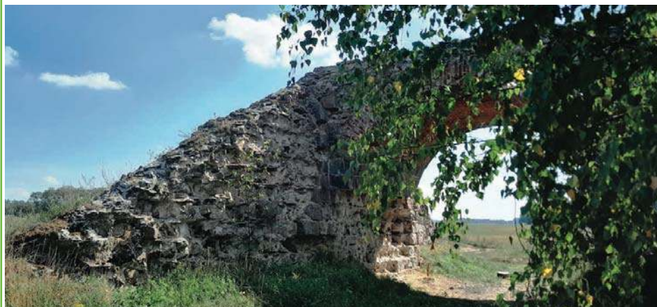
Ostatnie pozostałości po linii kolejowej Giżycko-Orzysz
