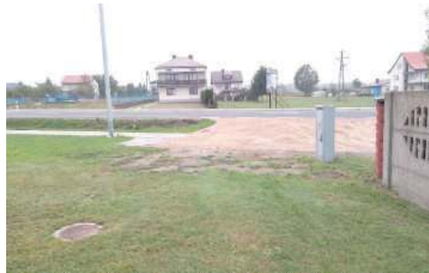
Wjazd z posesji pani Renaty. - Skrzynka energetyczna PGE umiejscowiona na środku podwójnego wjazdu stanowi utrudnienie, a wręcz przeszkadza przy wjeździe na działkę budowlaną, gdyż w dużym stopniu ograniczają manewr. Na pasie wjazdu są też dwie studzienki, po których nie należy jeździć i też trzeba je omijać - tłumaczy pani Renata
