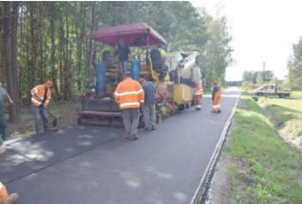
Przebudowa drogi w Karolówce kosztowała ponad 385 tysięcy złotych
