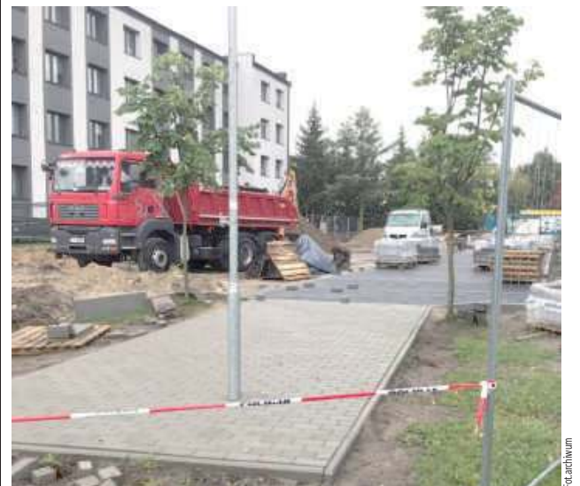
Parking przy Komendzie Policji w Biłgoraju w budowie
