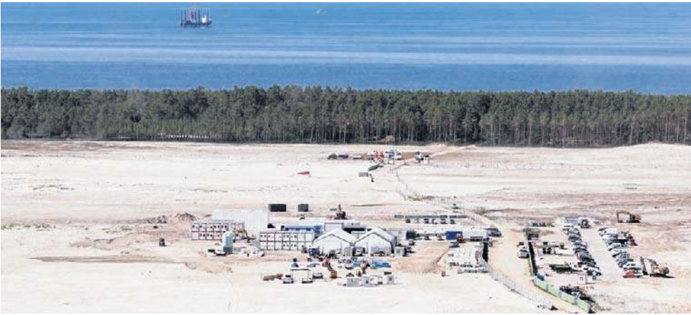
Zaawansowane prace na placu budowy elektrowni jądrowej w czerwcu tego roku
