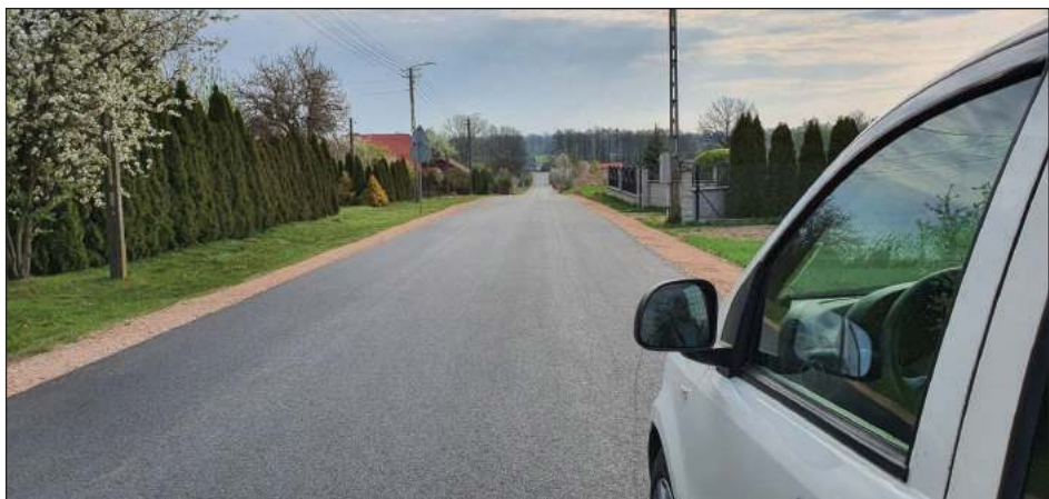
Remont drogi przeprowadzony został na odcinku 540 metrów i kosztował powiat garwoliński 345 tys. zł
