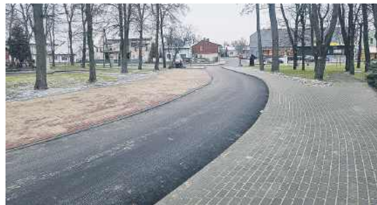
Wyremontowana ulica Kościelna w Siedliszczu
