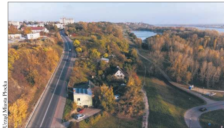
Fragment ulicy Kazimierza Wielkiego pozostanie zamknięty dla ruchu samochodowego do 18 grudnia
