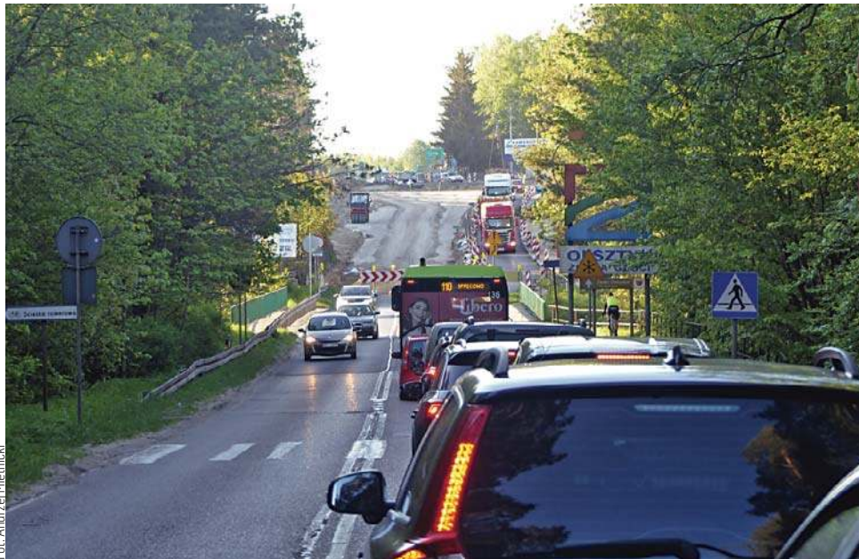
Rondo na skrzyżowaniu drogi 51 z drogą na Kieźliny ma być gotowe w lutym 2023 roku
