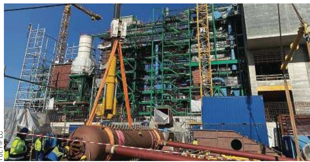
Fot. MPEC MPEC buduje ekociepłownię. Dzięki temu częściowo uniezależnimy się od węgla
