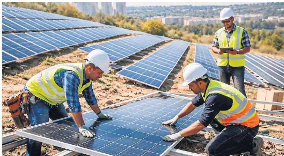
Spółka przeznaczy finansowanie z KPO na budowę farm fotowoltaicznych w Mysłowicach i Ogrodziencu
