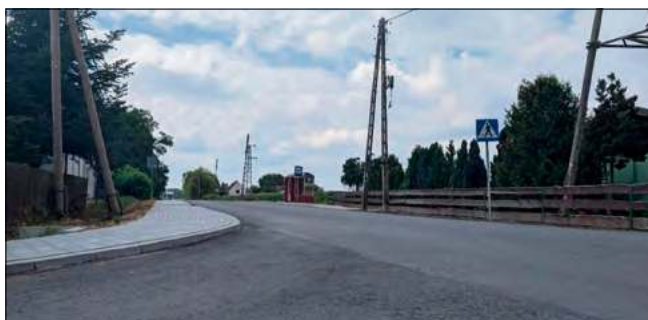
Remont drogi był realizowany w latach 2025–2026 w ramach zadania pn. „Remont drogi powiatowej Nr 1510 O na odcinku Niemodlin – Szydłowiec Śląski od km 1+132 do km 4+598 – etap II”.
