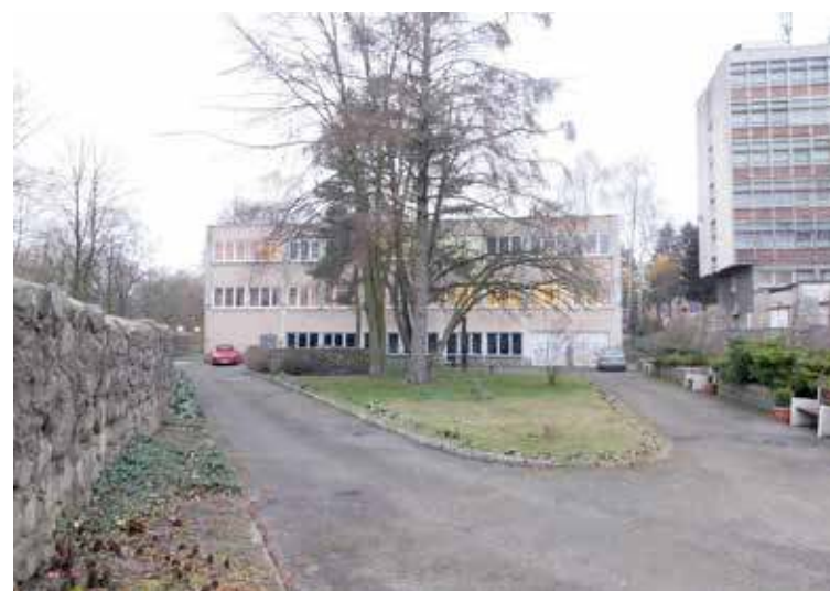
M.in. rewitalizacji ulegnie ogród biblioteczny znajdujący się w malowniczym miejscu tuż przy murach
