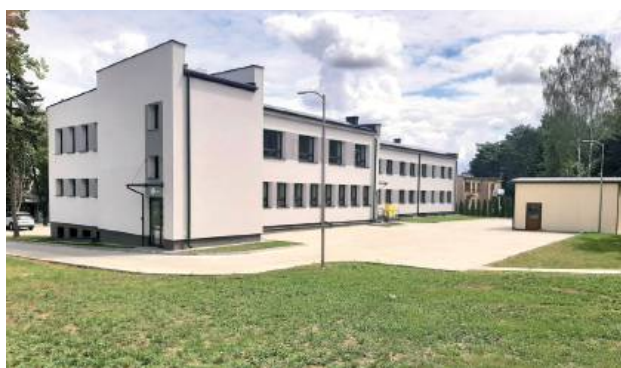
Stary budynek przychodni przeszedł generalny remont. Wkrótce pacjenci będą korzystać z nowego budynku
