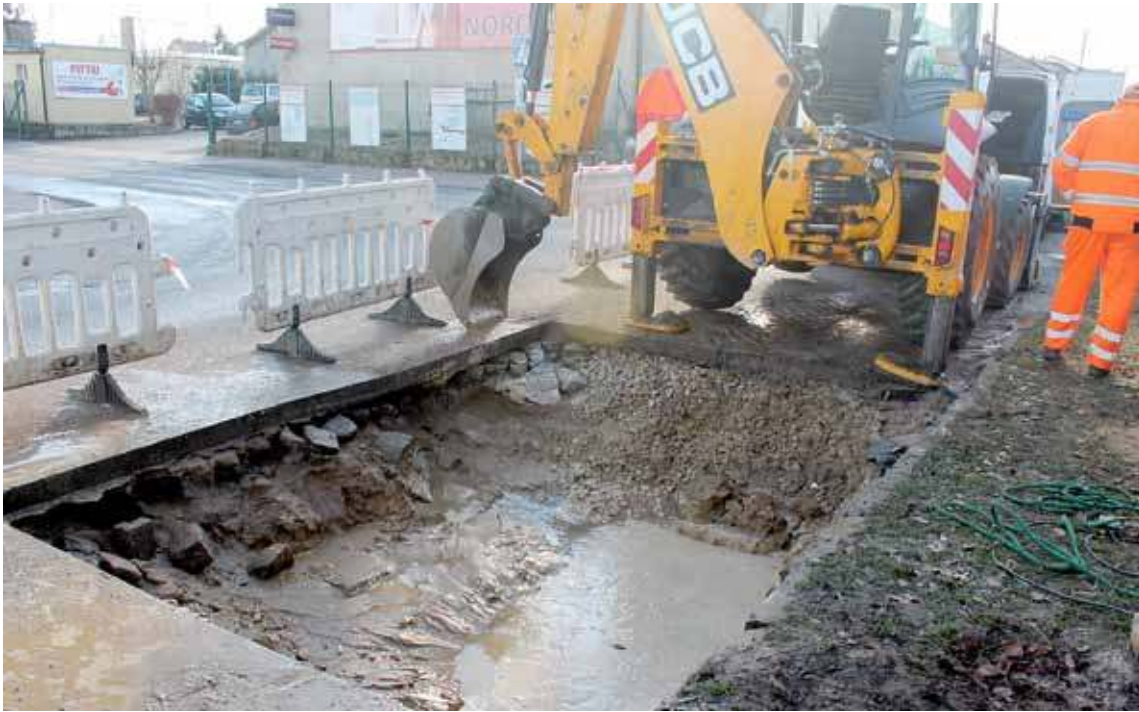
Aby dostać się do wodociągu znajdującego się pod ziemią, trzeba było wykopać ogromną dziurę
