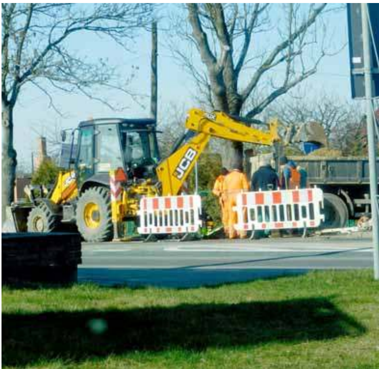
Prace przy usuwaniu awarii przyłącza wodnego przy ul. 3 Maja
