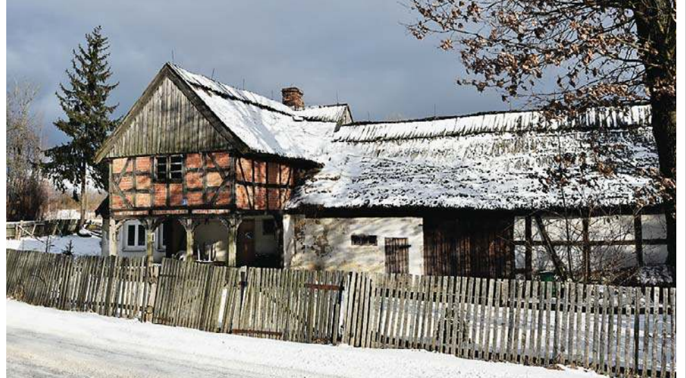
Łęcze. Dom powstały w 1846 r. z podcieniem w konstrukcji szkieletowej, wypełniony dekoracyjnie opracowanym szachulcem, usytuowany kalenicowo do drogi
