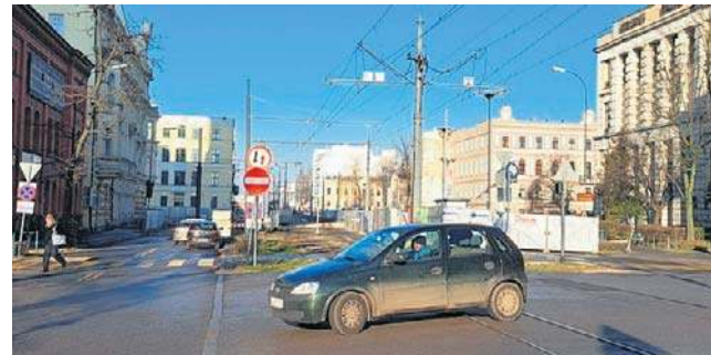
Skrzyżowanie Alei Kościuszki i Zielonej jest rozkopane od trzech lat, paraliżując ruch w mieście
