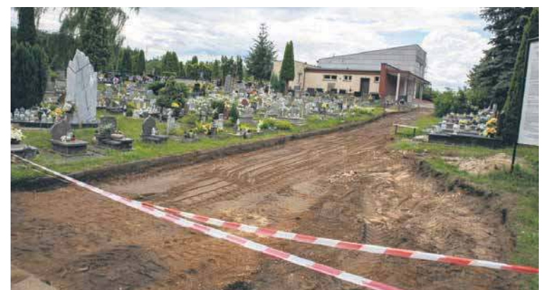
Chodniki przejdą gruntowny remont
