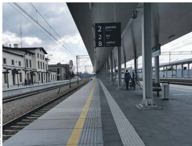
Jeden z przebudowanych peronów na stacji kolejowej w Trzebini
