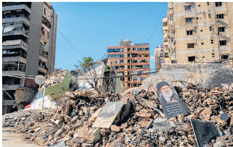
Zniszczone budynki na południowych przedmieściach Bejrutu. Tysiące mieszkańców po atakach trwających od marca zostało zmuszonych do opuszczenia swoich domów
