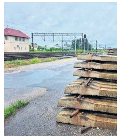
Po dokończeniu remontu tą trasą pojedziemy z prędkością 120 km/h
