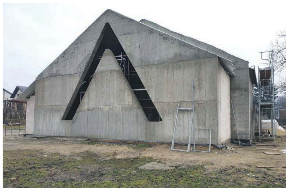
Widok budynku sakralnego od strony ul. Skorupki
