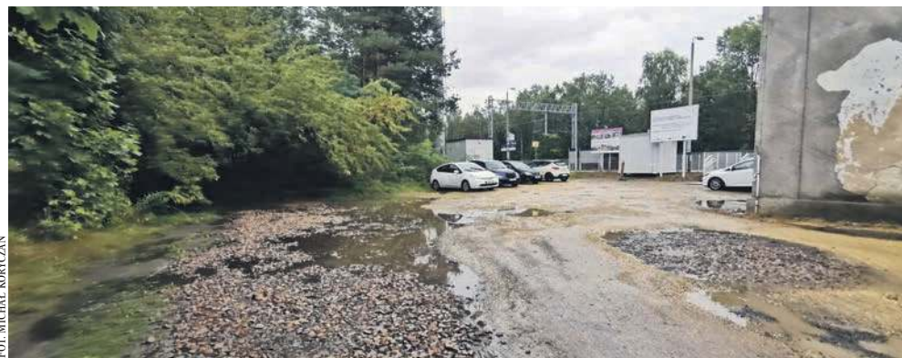
Teren w rejonie przystanku kolejowego w Dulowej
