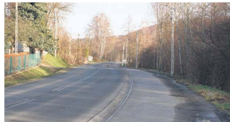
Ciąg pieszo-rowerowy wzdłuż ul. Prusa w Alwerni
