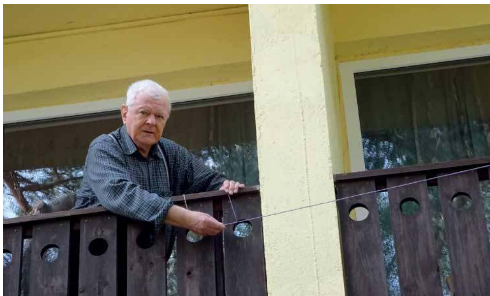
Ryszard SP4BBU instaluje antenę LW 27,2 m
