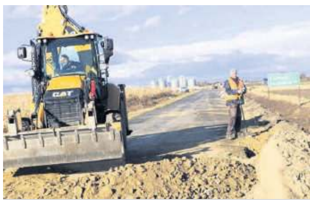
Dzięki środkom z Polskiego Ładu II kontynuowany będzie remont drogi powiatowej Wiązów – Jędrzychowice. Foto. archiwum
