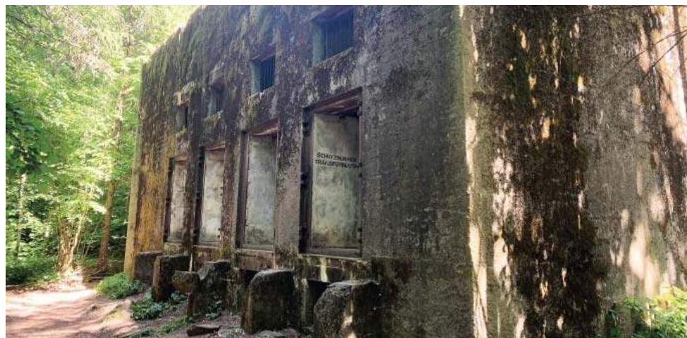
Bunkry dowodzenia niemieckiej armii w Mamerkach.
