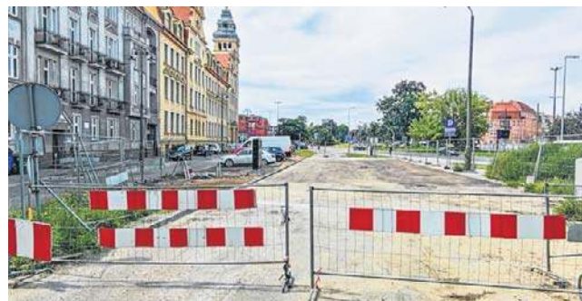
MWiK zapewnia, że na miejscu trwają już prace porządkowe (zdjęcia wykonane w środę 29 lipca)
