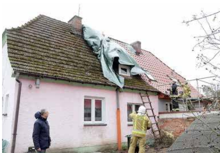
Instalacja planek w części dachu zniszczonej przez pożar
