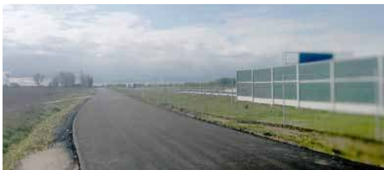
Najbliższy przystanek PKS, po oddaniu tego odcinka drogi S6, będzie znajdował się w Żabowie, czyli tuż za widocznym horyzontem
