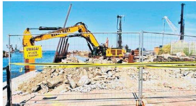
Rozbiórka falochronów w Ustce
