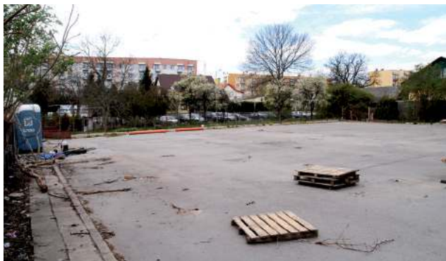
Targowisko zostało uprzątnięte. Prace zaczną się od zerwania starej nawierzchni asfaltowej
