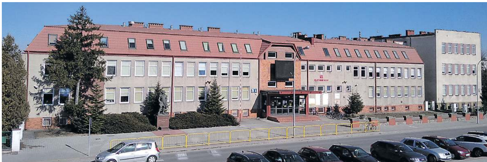
Wybrany w przetargu wykonawca będzie miał 21 miesięcy na termomodernizację budynków ZS nr 2 w Stalowej Woli
