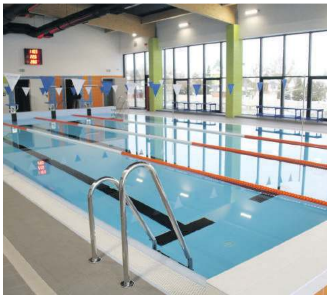
Na kryty basen dzieci będą chodzić na naukę pływania
