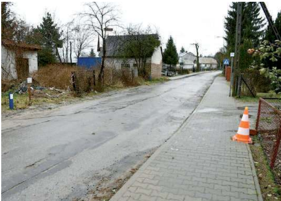
W tym roku droga przejdzie gruntowną modernizację. Prace ruszą, jak tylko pozwoli na to pogoda
