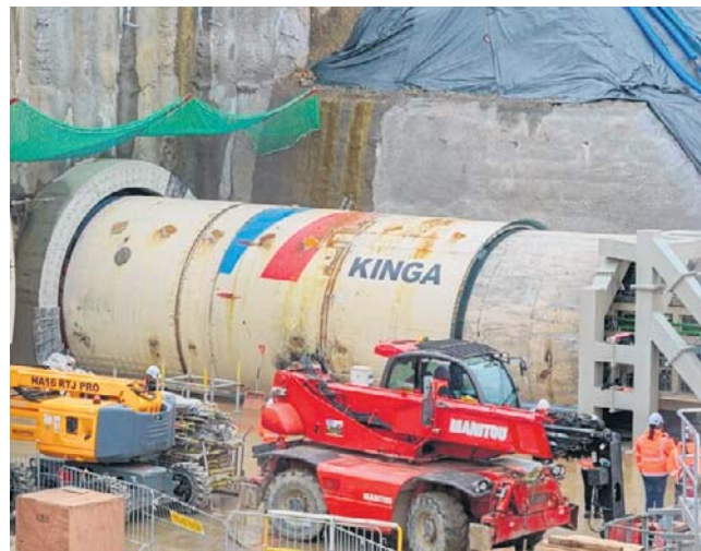
Kinga w Wilkowisku rozpoczęła drażnienie tunelu ewakuacyjnego. Ma już za sobą 100 metrów
