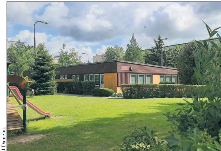
Dotychczasowy budynek przedszkola nr 17 zostanie wyburzony po zakończeniu budowy nowego obiektu
