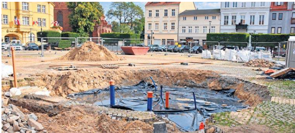
Plac jest dziś rozkopany, otoczony budowlanym płotem, a stara fontanna została już zdemontowana
