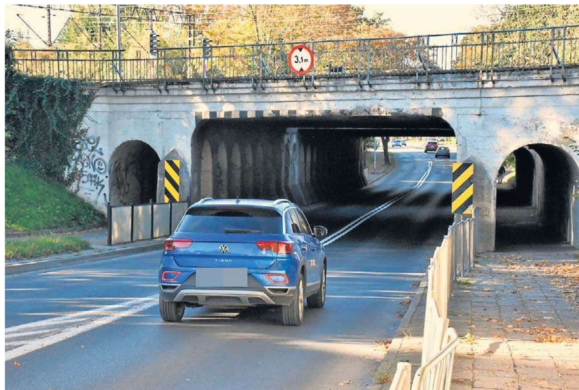
Wiadukt kolejowy nad ul. Szczecińską liczy sobie już ponad 150 lat. Jest dziełem pruskich architektów, a powstał w 1870 roku. Nie jest jednak ujęty w spisie zabytków – należy do Polskich Kolei Państwowych
