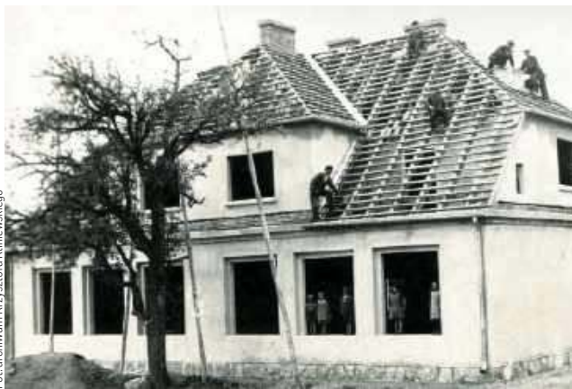
Prace ciesielskie na dachu domu jednorodzinnego
