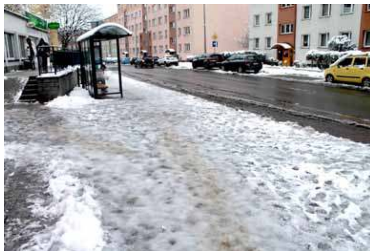
Oblodzony chodnik na ul. Krzywoustego
