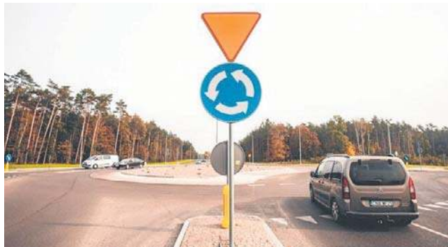
W regionie zaplanowano przebudowę 23 skrzyżowań
