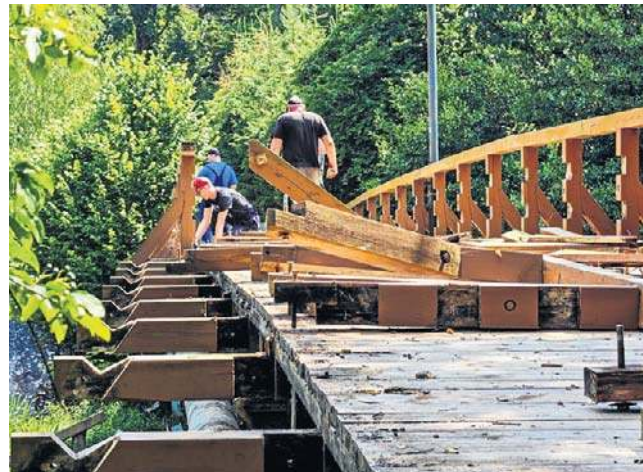
Remont kładki dla pieszych w Smukale nad Brdą, między ulicami Opławiec i Baranowskiego rozpoczął się w piątek 10 lipca
